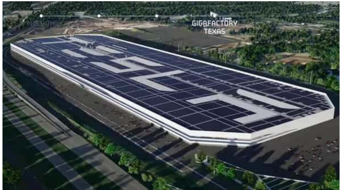
Gigafactoría de Tesla en Texas, USA, con capacidad de hasta 100 GWh (Fuente: Tesla)
